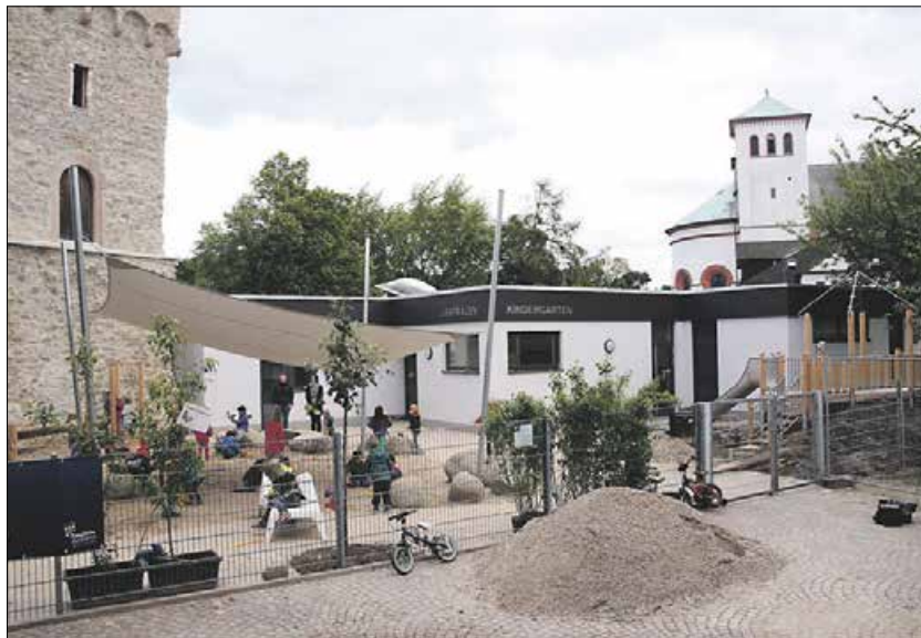
Der Bensheimer Kindergarten Liebfrauen wurde bei der Sanierung um den Bereich für eine neue Gruppe für Zweijährige erweitert. Foto: Karin Weber
